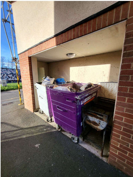
Bin Store (Waste Disposal Area)
